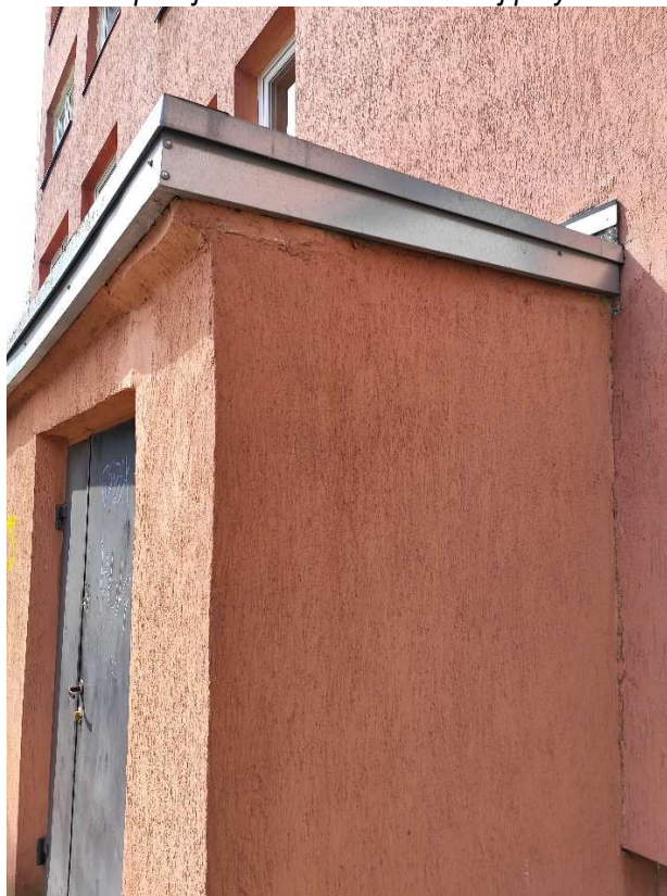
Fot. 2. Widoczne uszkodzenie na styku ściany dobudowanego pomieszczenia do budynku mieszkalnego wielorodzinnego
