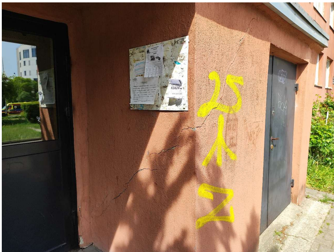
Fot. 3. Widoczne pęknięcia na ścianach murowanych.
