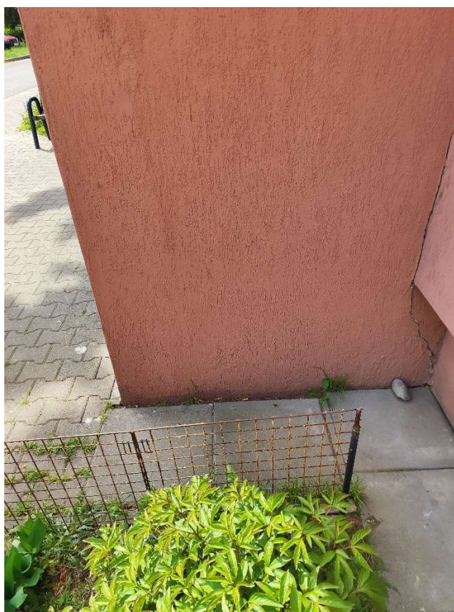
Fot. 4. Widoczne pęknięcia na stryku budynku
