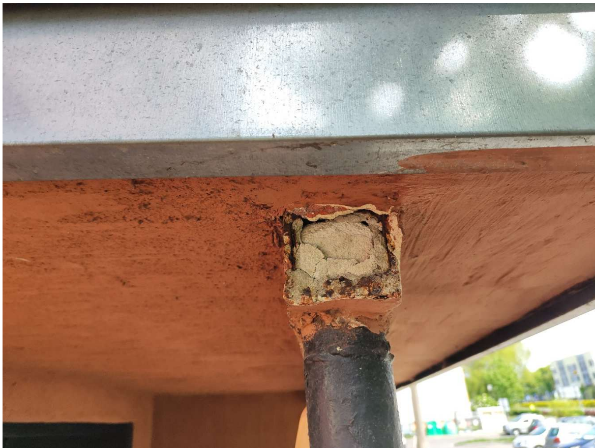
Fot. 7. Element podpierający płytę żelbetową
