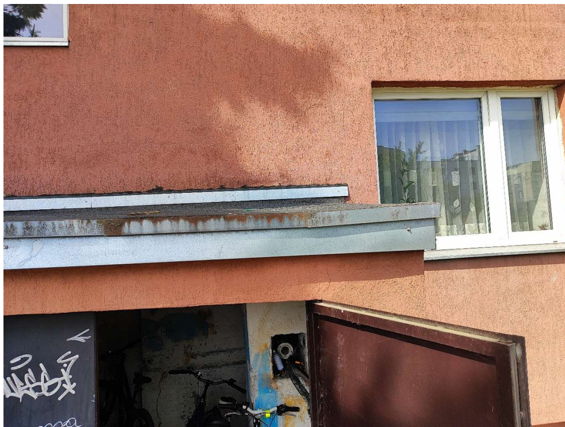
Fot. 5. Pokrycie płyty żelbetowej
